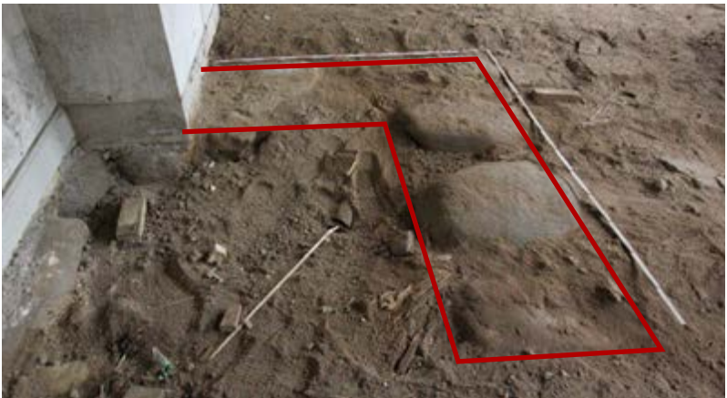
ILDSTED 1: Fundament af gammelt ildsted fundet i vestvendt sal. Store syldsten lå under det eksisterende gulv og vidner om et ildsted på op til 2 meter bredt og næsten 2 meter dybt. Bjælkerne er affaset og viser det gamle ildsteds store kappe.
