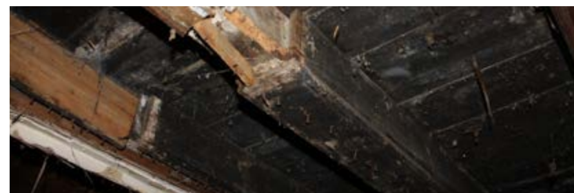
K.Original inddækning af bjælke, bevaret
