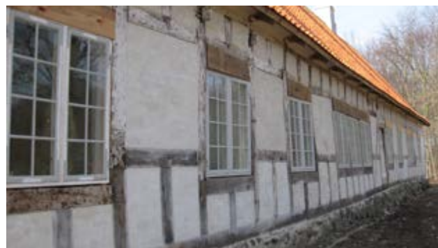
Facaderne tager form ved vinduernes indsættelse
