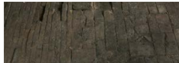
Teglgulv, under gulv i gl. køkken
