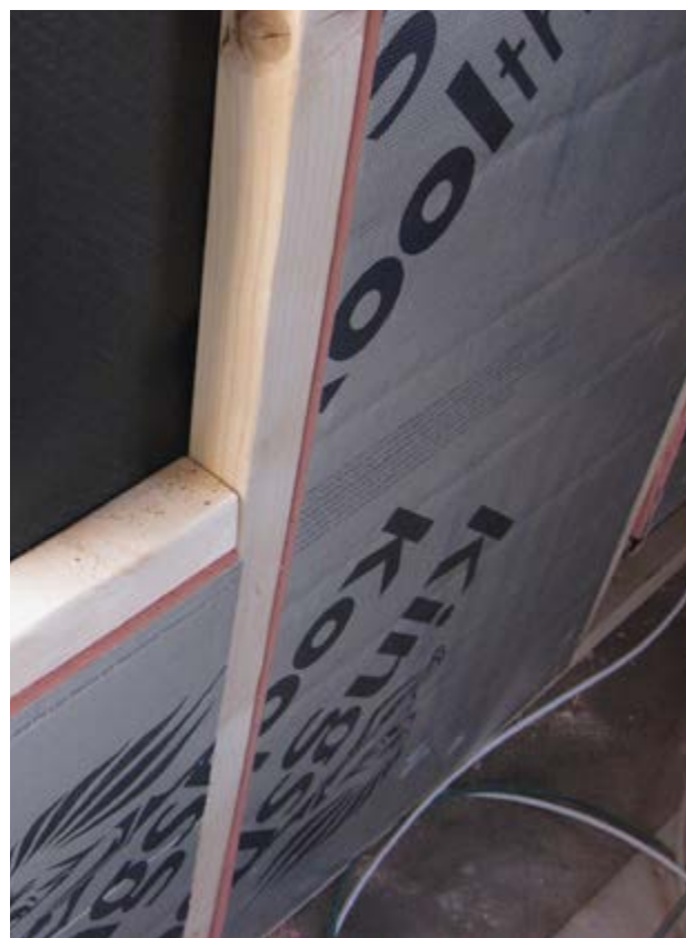
Højisoleringsplader i hårdt skum på ydervæggene
