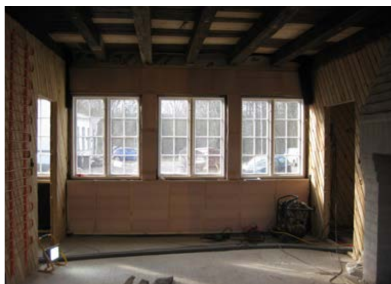
Rummene får form her det gennemlyste salsrum der opstår af lette indervægge, vægvarme, isolering, vinduer, ildsted, istandsatte lofter etc.
