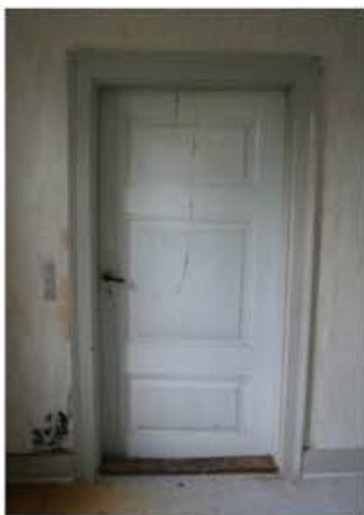
ID: 0.03 Sen 1700-talsdør med tre kannelerede fyldninger
