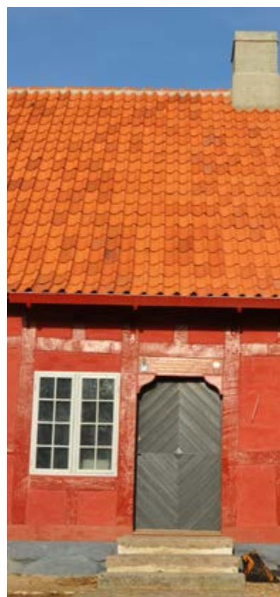
Hovedadgangen genskabt med ny bosse-dør, dørhammer, og granittrin
