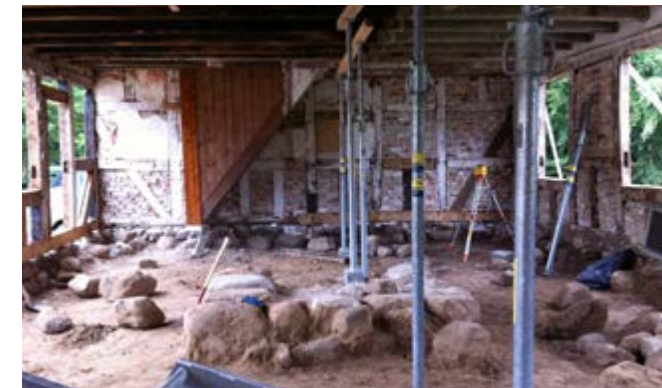
Sals ildsted - fundament
