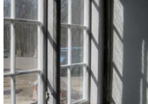
Lysindfald gennem de nyindsatte vinduer, der er genbrug fra herregården Trøjborg
