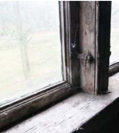
Gavlvinduerne barokke post, med barokke anverfere
