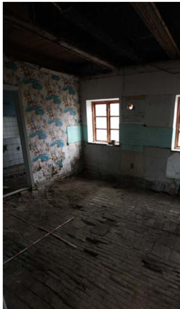
Teglgulv i det gamle køkken registreres
