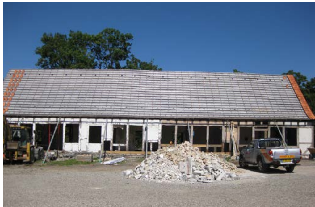
2012 - Forår / sommer, tagoplægning påbegyndes
