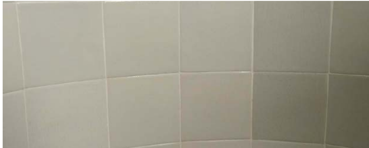
Hollandske fliser i bruseniche, opsat med knasfuge
