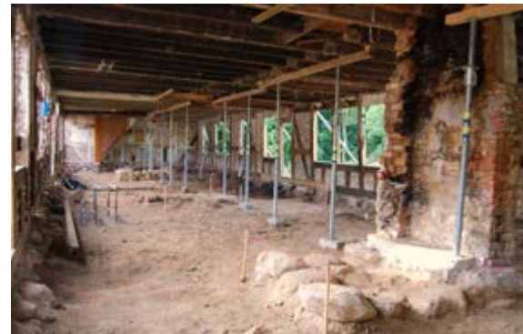
De tre fundamenter for ildsteder med køkken ildsted forrest
