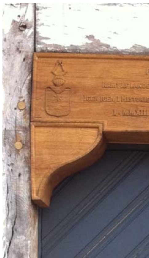
Gl. anboringer genbruges for montering af ny dørhammer
