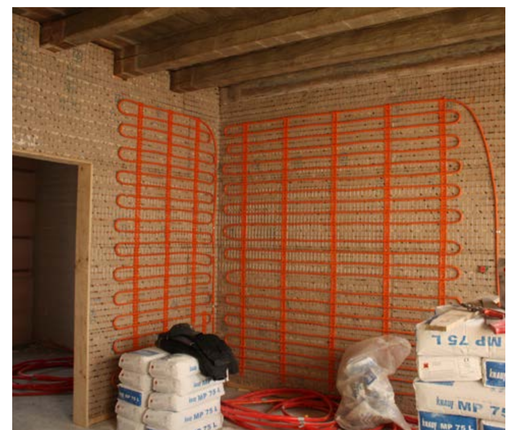
Vægvarme montering. Klar til opkastning af puds
