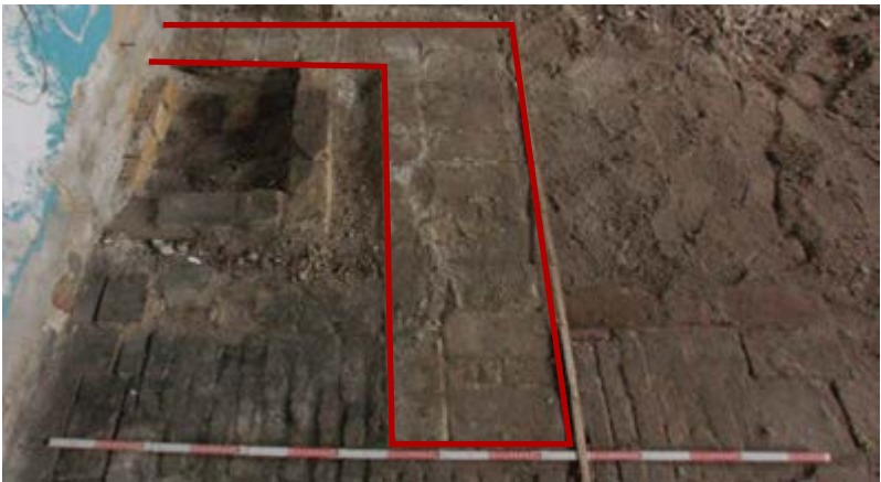
ILDSTED 2: Det midterste ildsted er lidt mindre end de to øvrige. Det oprindelige omfang er stadig synligt, affasning af de gamle bjælker og fornyelse af loftbrædder, omend det er ombygget af flere omgange. Det senere skorstens fundamentet er bygget midt i det oprindelige ildsted.
