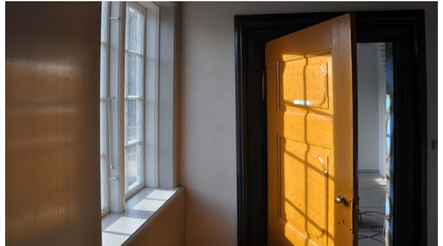
Panelvæge i gråtoner, pudsede vægge i umalet gipsmørtel, mørk grå dørgerichter og guldokkerfarvet dør med farvetrappe
