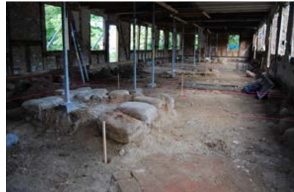
De tre fundamenter med sals ildstedet forrest
