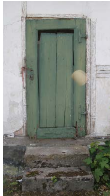
Tidlig barok inderdør, hængslet på bindingsværksstolpe, nordfacade
