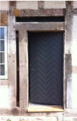
Ny flammeret dør til køkken
