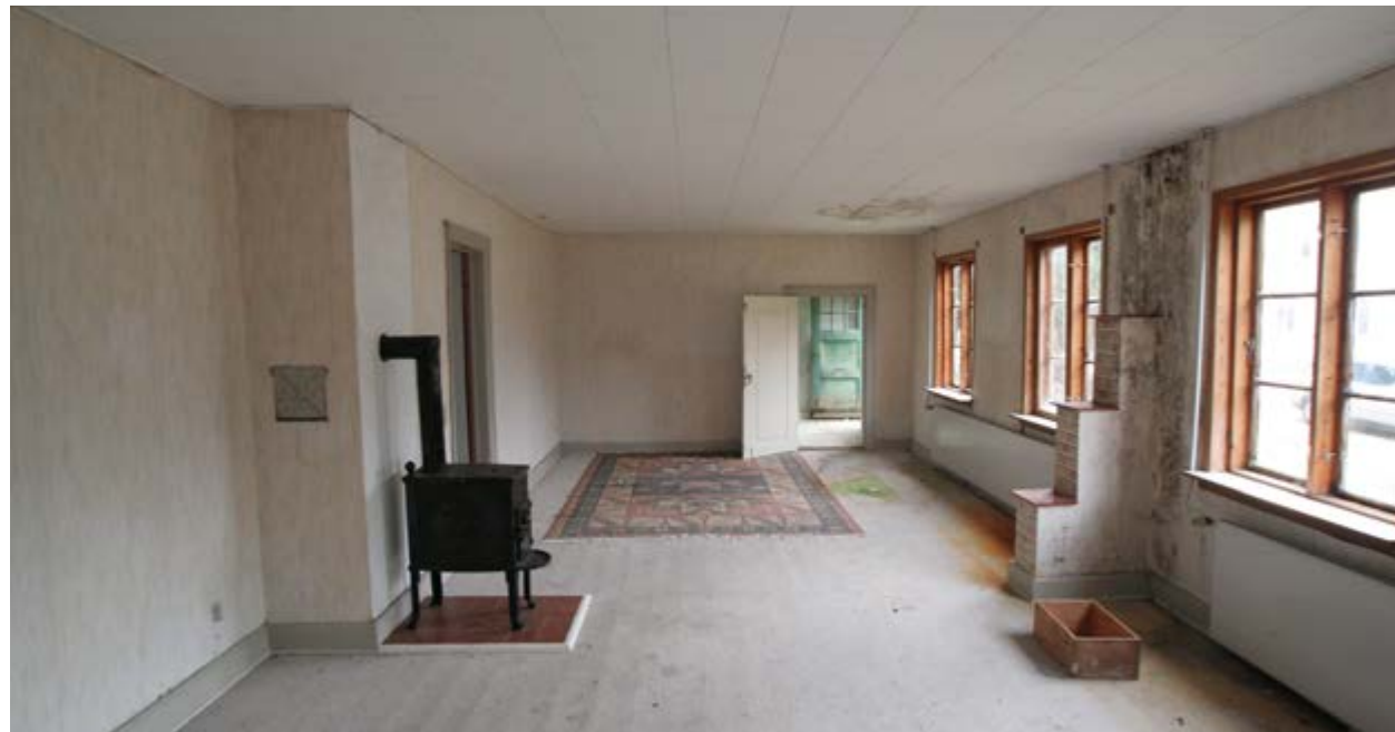
A. Stue. Enfyldningsdør fra tidlig 1700-tal til entré (ID. 0.08)
