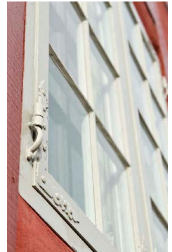
Vinduer er monteret med genbrugsglas, hjørnebåndshængsel, kitfals mm.
