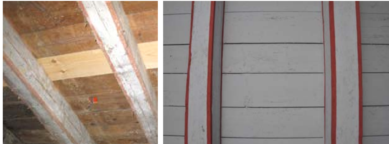
Velbevaret maling på bjælker i indgangsrummet, blev nænsomt retoucheret
