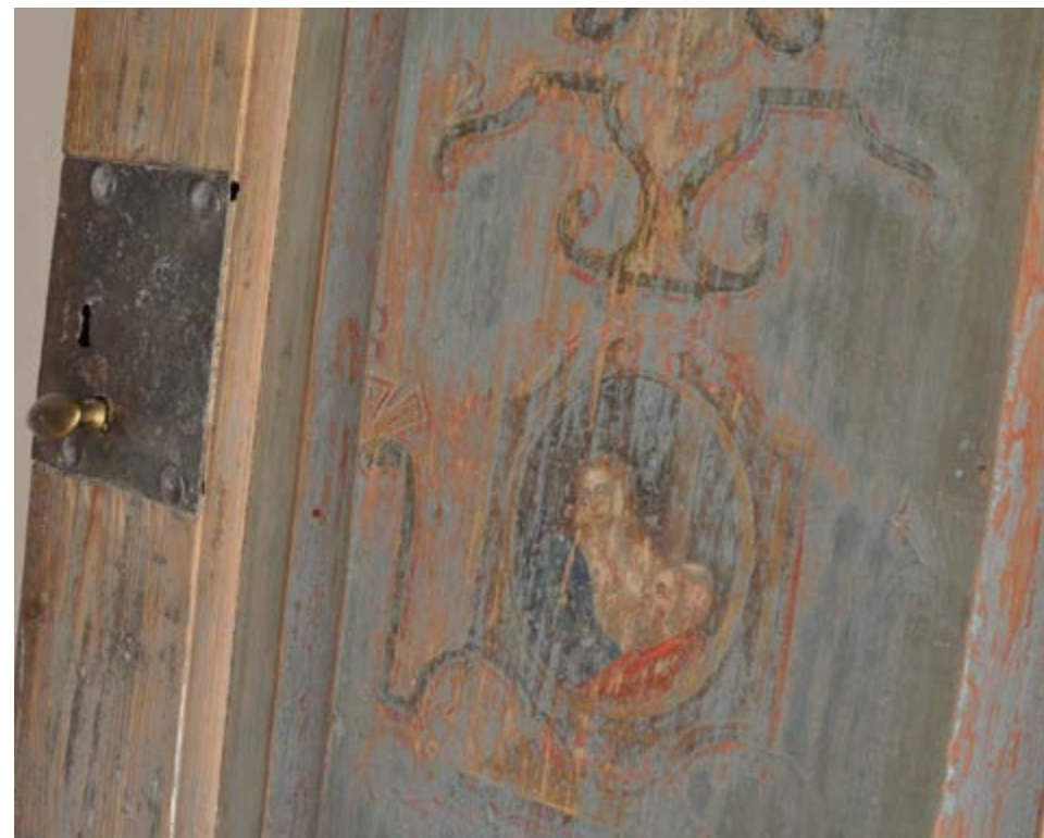
Enfyldningsdør med figurativ fremstilling på fyldning, barok låsekasse mm.
