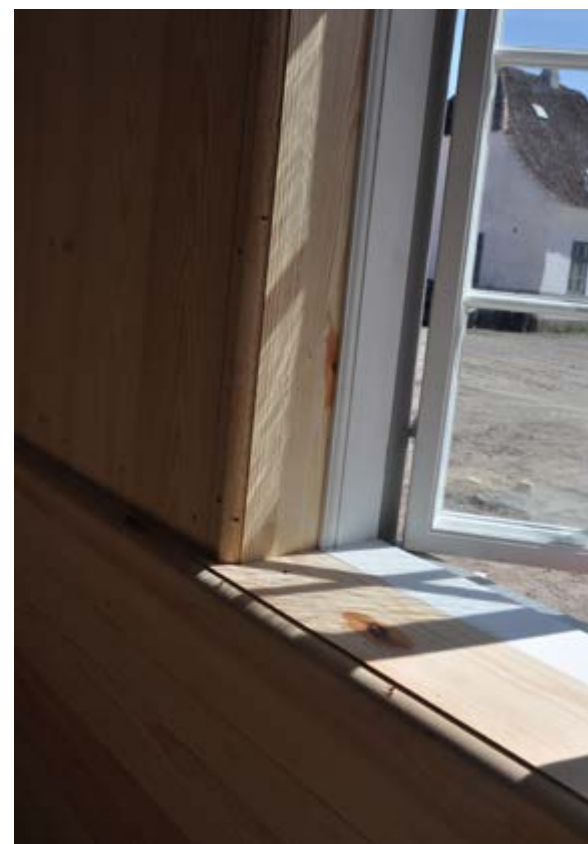
Ydervæg beklædt med plankepaneler. Den tynde isoleringstykkelse sikrer autentiske vægtykkelser
