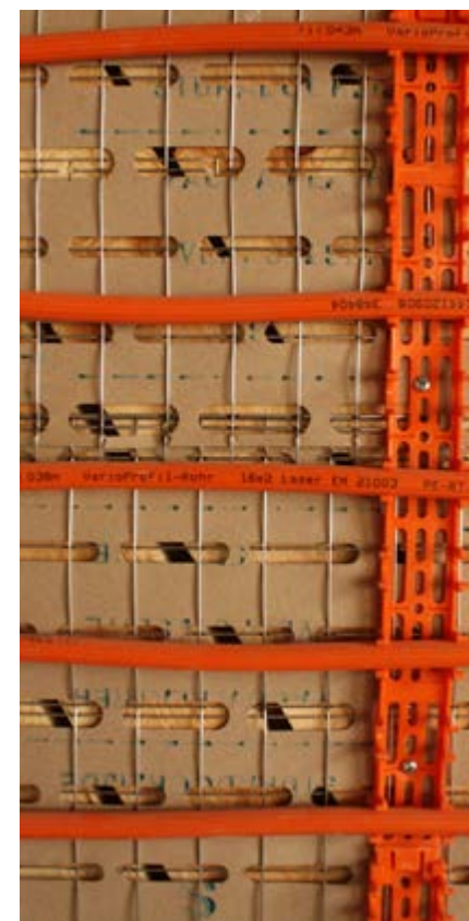
Vægvarme montering. Spanske vægge, net for binding af puds, vægvarme
