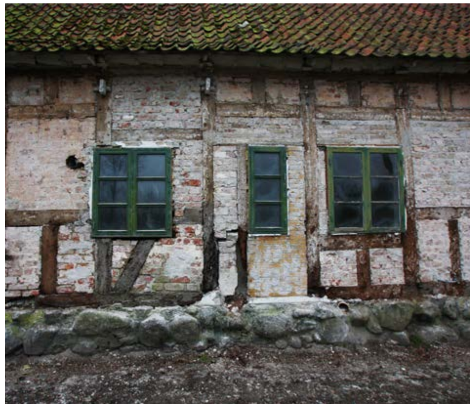
Fritlagt bindingsværk og tværl. Irregularitet i bindingsværkets rytme
